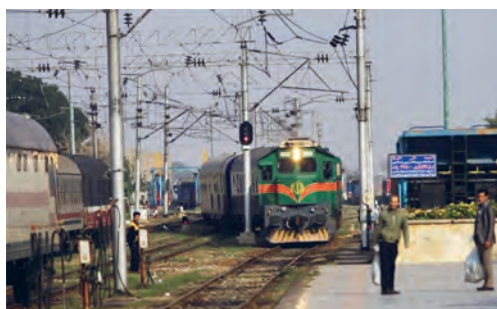
شکل ۲۴ - ایستگاه راه آهن ساری
